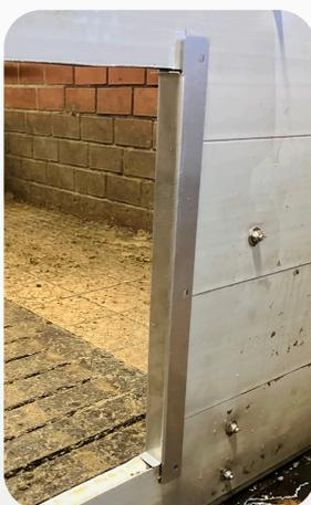
4. Befestigen Sie die Seitenprofile mit den Schrauben (M6 x 45).
