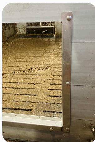
5. Installieren Sie die Kopf- und Fußprofile ebenfalls mit Schrauben (M6 x 45).
