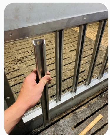
6. Montieren Sie die sieben Striben mit Schrauben (M6 x 16).
