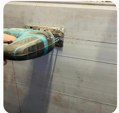
3. Schneiden Sie den angezeichneten Ausschnitt mit der Stichsäge aus.
